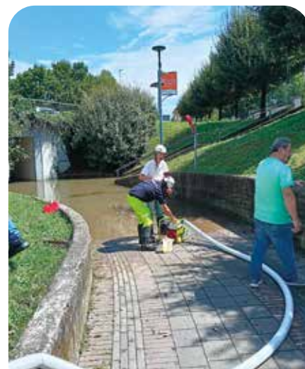
Intervento Protezione Civile per allagamento sottopassaggio
