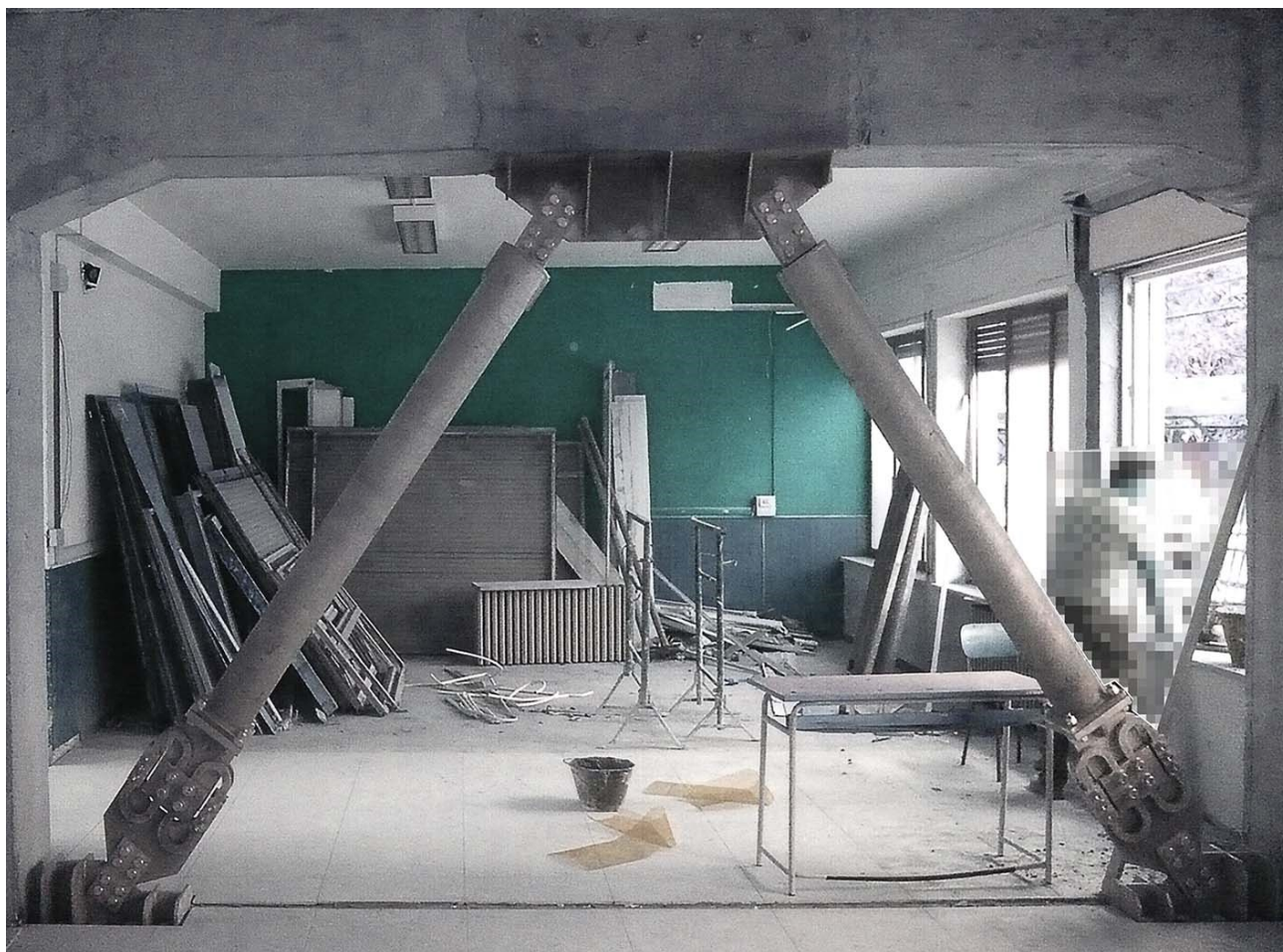
Installazione di controventi dissipativi
