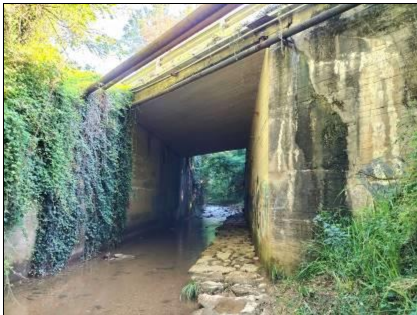
Fig. 13.10 - Dettaglio del ponte della SP 166 vista da Sud. Si notano i tubi dei servizi e la passerella pedonale lungo il greto del torrente (punto da cui è stata misurata l'altezza del ponte)
