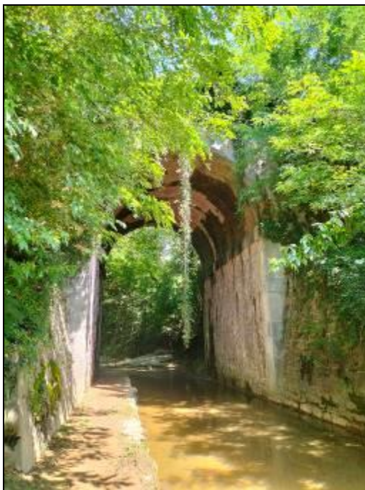
Fig. 13.12 - Ponte della ferrovia, da Sud.
