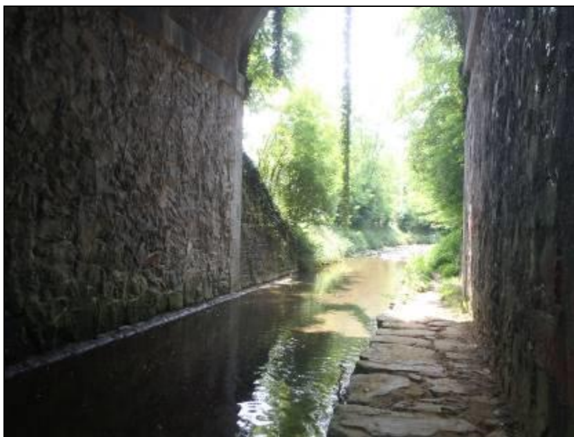
Fig. 13.11 - Dettaglio del ponte della ferrovia, da Nord. Si nota l'ampia luce del ponte. Oltre il ponte della ferrovia si vedono le sponde del t. Buliga. Dai dati desumibili dal progetto di "Messa in sicurezza idraulica del torrente Buliga e affluenti dai crolli spondali (Ecosphera, 2021)" le sponde sono in grado di contenere la piena dei 100 anni.
