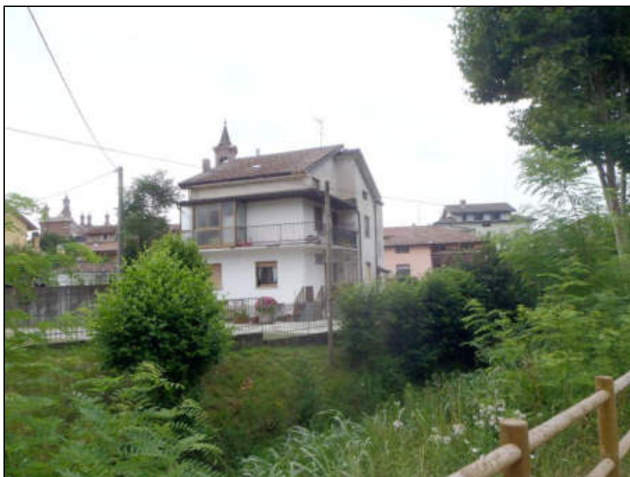
Fig. 7.6a - Edificio in sponda sinistra (edificio 1a di fig. 7.5), visto dalla sponda destra del T. Buliga. Si nota il muretto di sostegno della recinzione.
