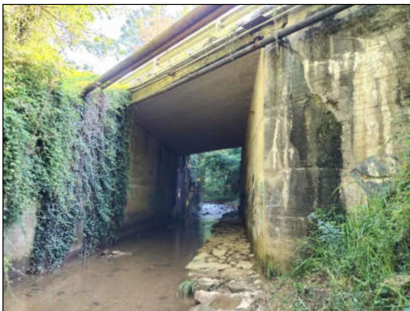
Fig. 7.1 - Dettaglio del ponte della SP 166 vista da Sud. Si notano i tubi dei servizi e la passerella pedonale lungo il greto del torrente (punto da cui è stata misurata l'altezza del ponte)
