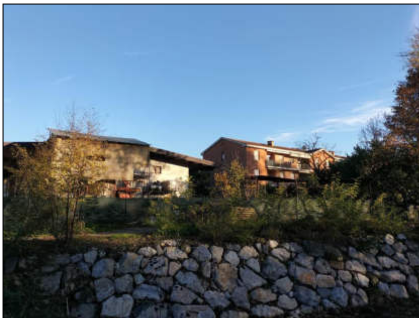
Fig. 7.18 - Vista del capannone presenti sulla via San Donato (l'accesso è sulla via Rota) indicato con il numero 2a di fig. 7.16 (a sinistra); a destra, davanti alla casa arancione è visibile la tettoia indicata con il numero 2b nella stessa fig 7.16. Vista dalla sponda destra del T. Buliga.
