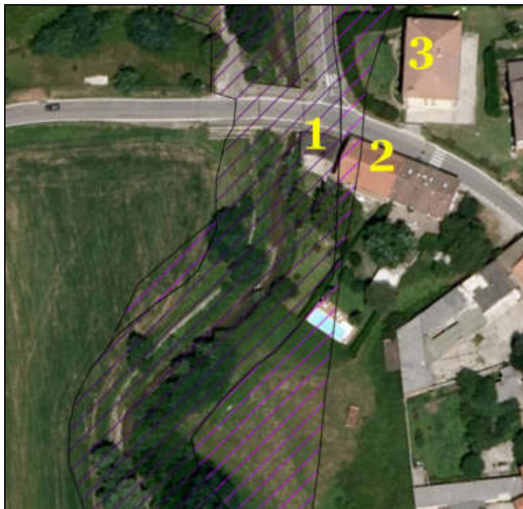
Fig. 7.23 - Area a sud del Ponte di via Medolago. In barrato viola chiaro le aree P2/M, in barrato viola scuro quelle P3/H. Per la spiegazione dei numeri, vedi testo
