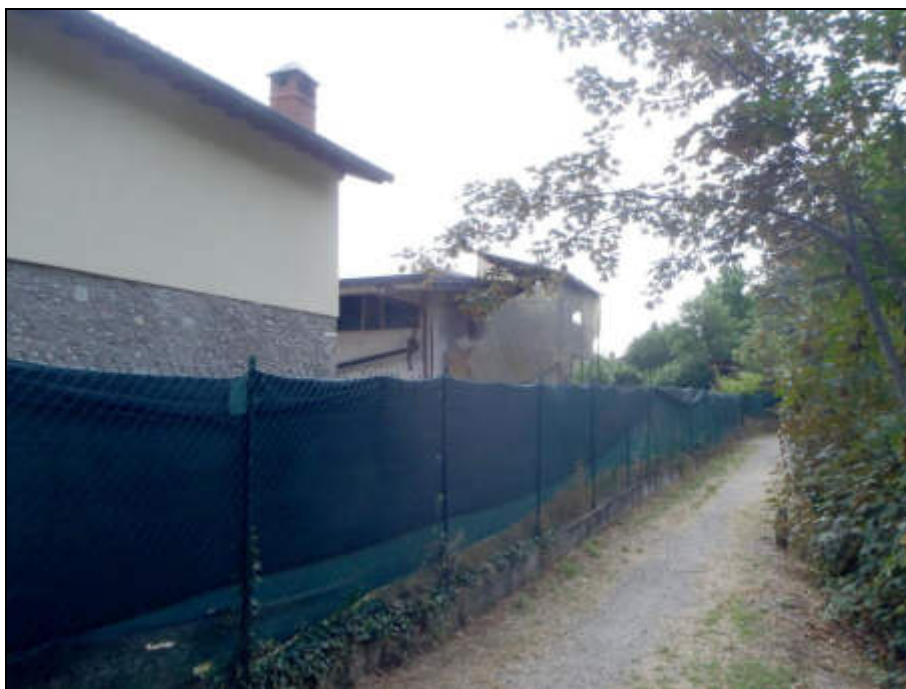
Fig. 7.17a - Vista degli edifici presenti sulla via San donato (l'accesso è sulla via Rota); in primo piano l'edificio 1 di fig. 7.16, in secondo piano il capannone ad uso agricolo, indicato con 2a nella stessa fig 7.16. Si nota il muretto alla base della recinzione.
