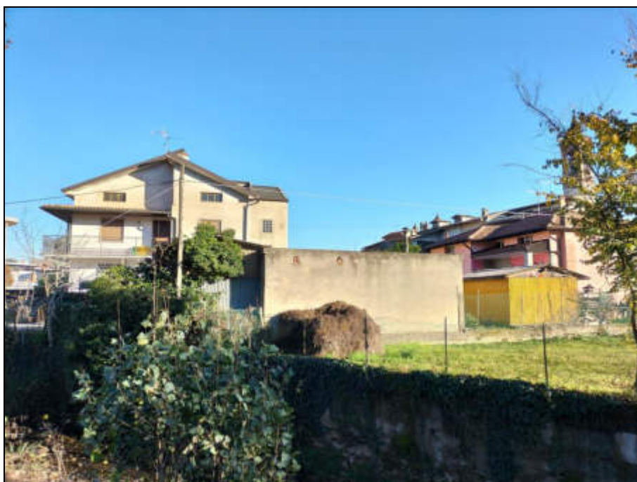
Fig. 7.6b - Edificio in sponda sinistra (edificio 1 di fig. 7.5), visto dalla sponda destra del T. Buliga. In primo piano è visibile l'edificio 1b, sullo sfondo l'edificio 1a.
