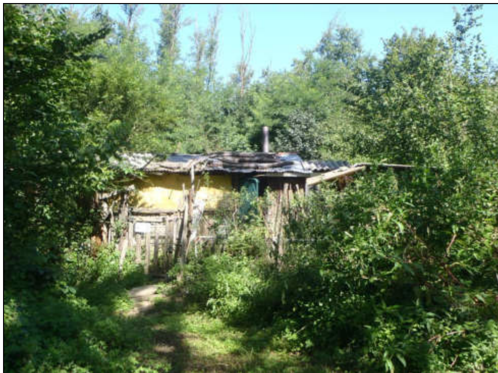
Fig. 7.25 - Baracche lungo la valle del torrente Luf, in sponda sinistra. Vista dal pianalto.
