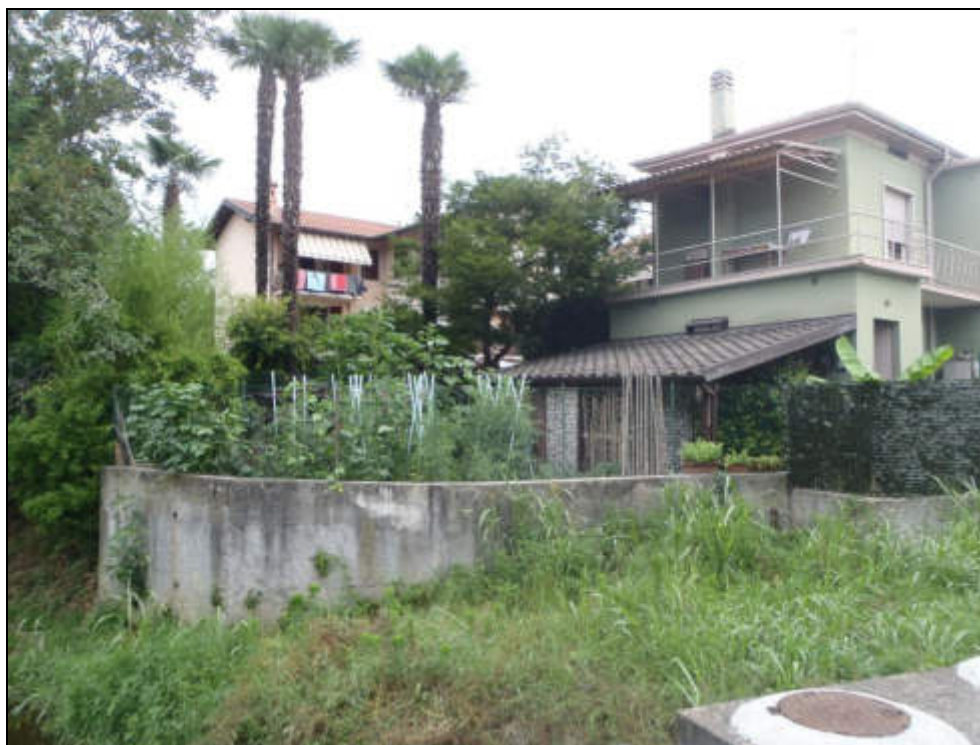
Fig. 7.12 - Edificio in sponda sinistra a Nord del ponte di via Mercato, indicato numero 3 in fig. 7.9. Si nota il muro di protezione in corrispondenza del torrente Buliga.
