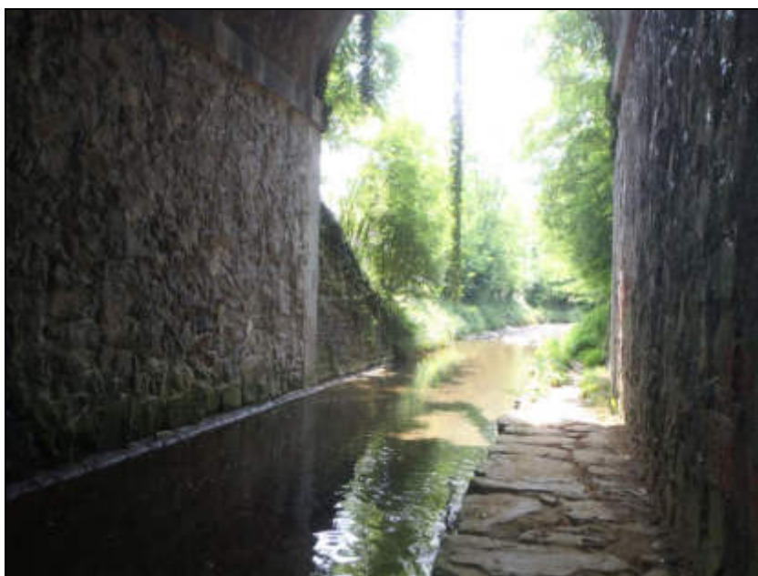
Fig. 7,2 - Dettaglio del ponte della ferrovia, da Nord. Si nota l'ampia luce del ponte. Oltre il ponte della ferrovia si vedono le sponde del t. Buliga. Dai dati desumibili dal progetto di "Messa in sicurezza idraulica del torrente Buliga e affluenti dai crolli spondali (Ecosphera, 2021)" le sponde sono in grado di contenere la piena dei 100 anni,
