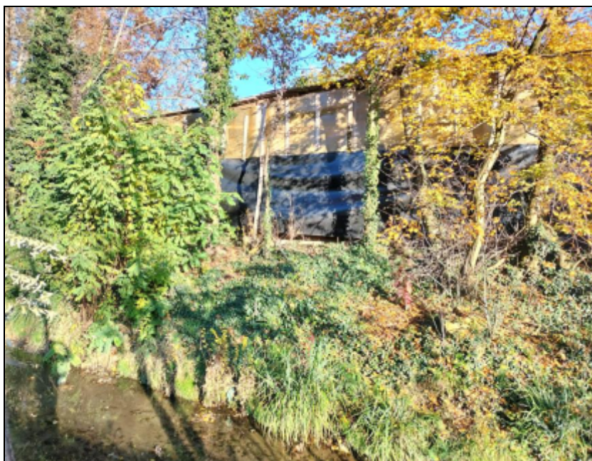
Fig. 7.11b - Scorcio della tettoia indicata con il numero 2 in fig. 7.9.
