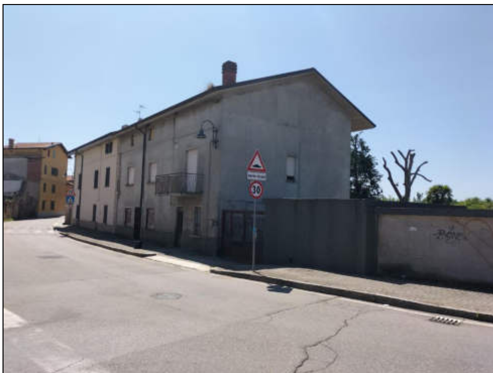
Fig. 7.24 - Edifici lungo la via Medolago (lato Sud, in sinistra del T. Buliga). In primo piano l'edificio ad uso box, in secondo piano (dopo il cartello stradale) le abitazioni.
