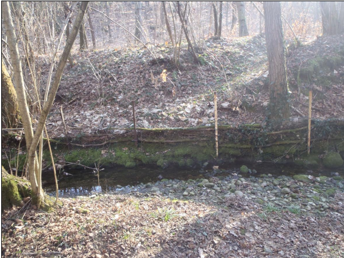
Fig. 6.3 - Esempio di difesa spondale "artigianale" lungo le sponde di uno dei corsi d'acqua che tagliano il pianalto
