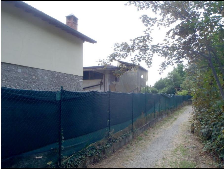
Fig. 13.26a - Vista degli edifici presenti sulla via San donato (l'accesso è sulla via Rota); in primo piano l'edificio 1 di fig. 13.25, in secondo piano il capannone ad uso agricolo, indicato con 2a nella stessa fig 13.25. Si nota il muretto alla base della recinzione.
