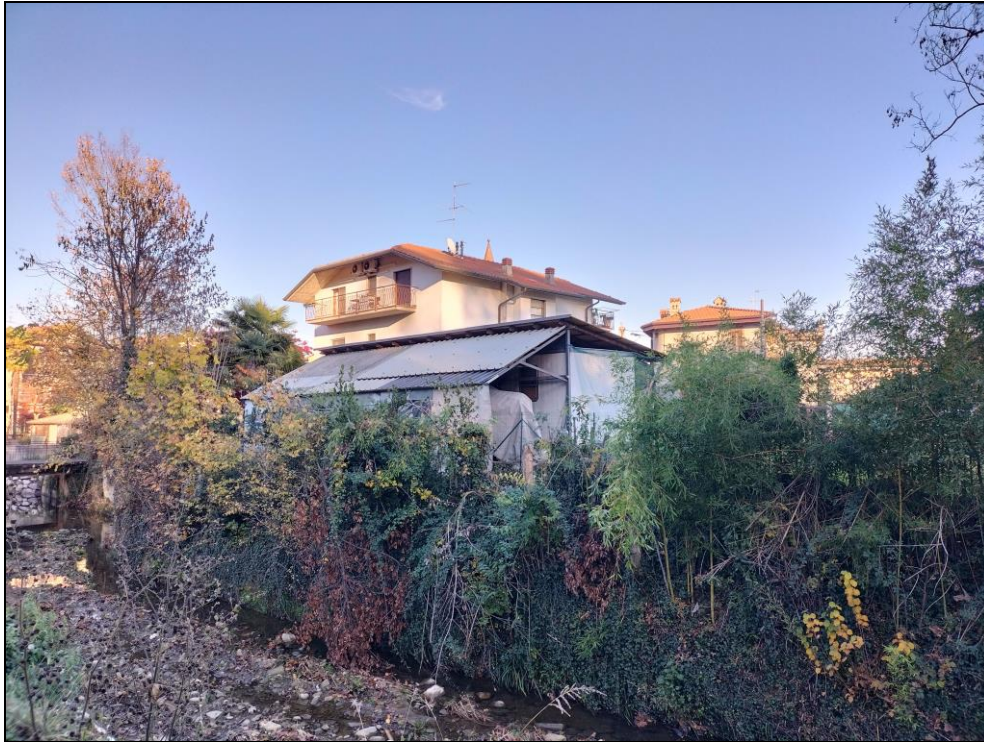
Fig. 13.23 - Tettoia a protezione di un container usato come magazzino/ripostiglio (3 in fig. 13.22) visto dalla sponda destra del T. Buliga.
