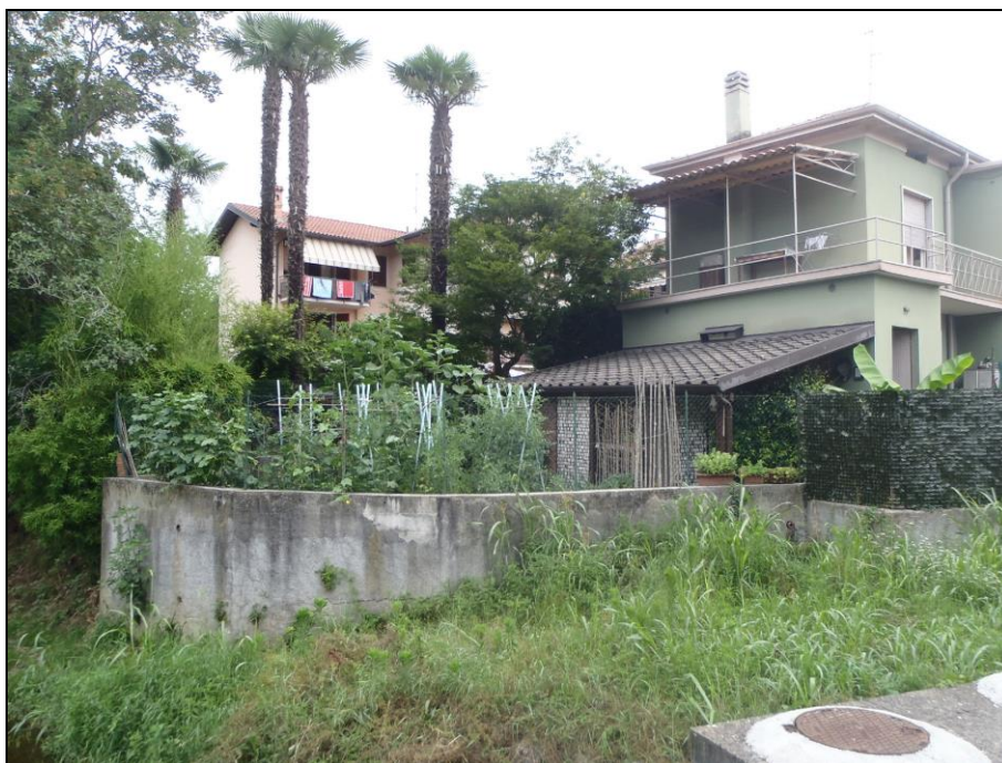
Fig. 13.21a - Edificio in sponda sinistra a Nord del ponte di via Mercato, indicato numero 3 in fig. 13.18. Si nota il muro di protezione in corrispondenza del torrente Buliga.
