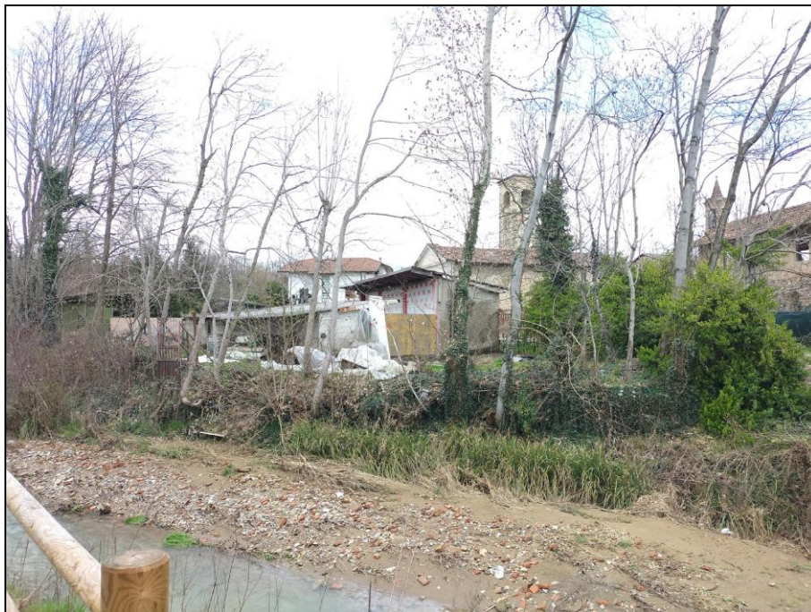
Fig. 13.24d - Vista dalla sponda destra delle costruzioni indicate in fig. 7.13 con i numeri 4 (a sinistra) e 5 (a destra).
