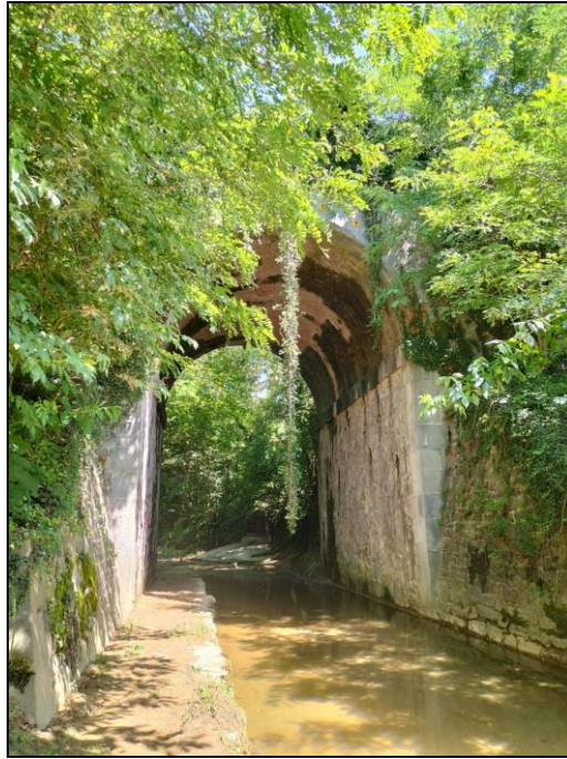
Fig. 13.12 - Ponte della ferrovia, da Sud.
