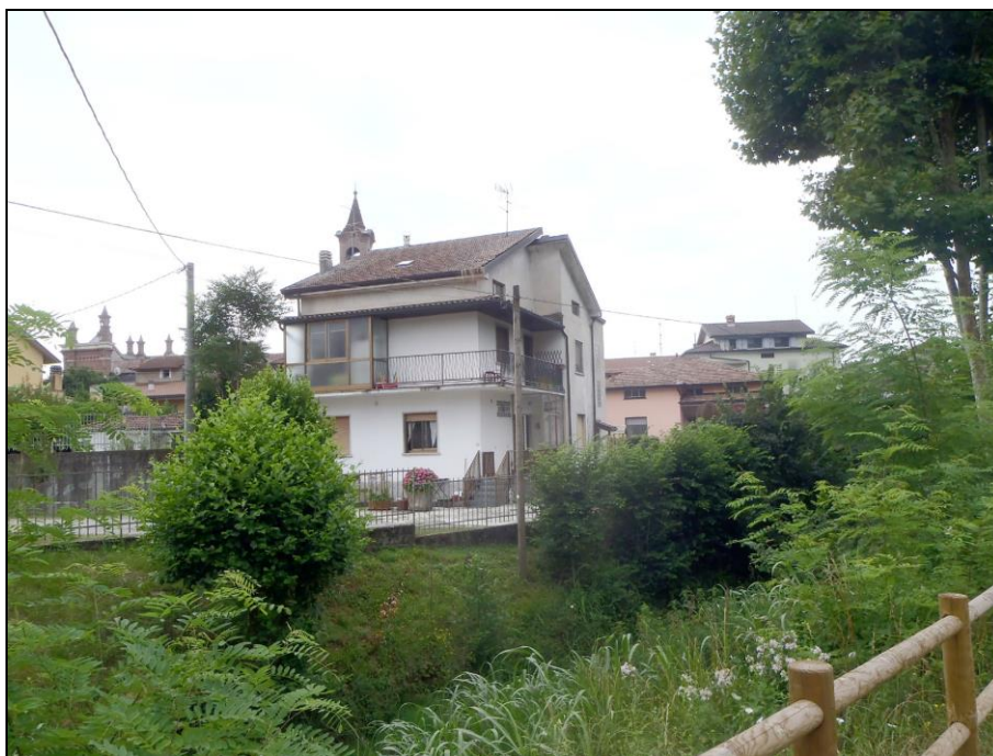
Fig. 13.15a - Edificio in sponda sinistra (edificio 1a di fig. 7.5), visto dalla sponda destra del T. Buliga. Si nota il muretto di sostegno della recinzione e i gradini che portano all'ingresso dell'abitazione.
