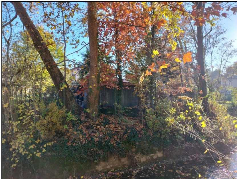
Fig. 13.20a - Tettoia in lamiera a nord della tettoria segnata con il numero 2 in fig. 13.18.
