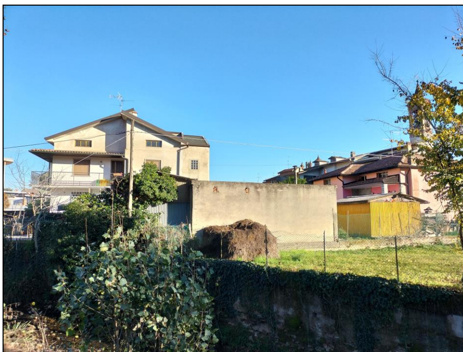
Fig. 13.15b - Edificio in sponda sinistra (edificio 1 di fig. 13.4), visto dalla sponda destra del T. Buliga. In primo piano è visibile l'edificio 1b, sullo sfondo l'edificio 1a.
