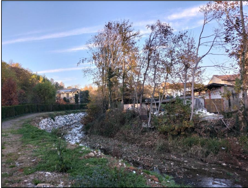
Fig. 13.24c - Vista dalla sponda destra delle costruzioni indicate in fig. 7.13 con i numeri 4 (a sinistra) e 5 (a destra).
