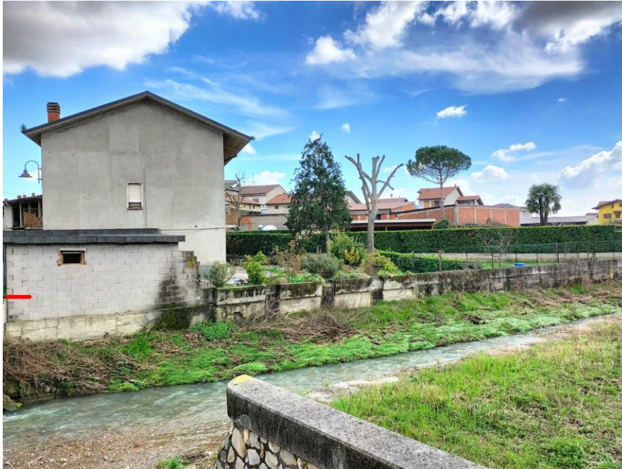
Fig. 13.33b - Edifici lungo la via Medolago (lato Sud, in sinistra del T. Buliga). Si vede il giardino a ridosso del T. Buliga, Il tratto rosso indica il livello stradale in corrispondenza del ponte.
