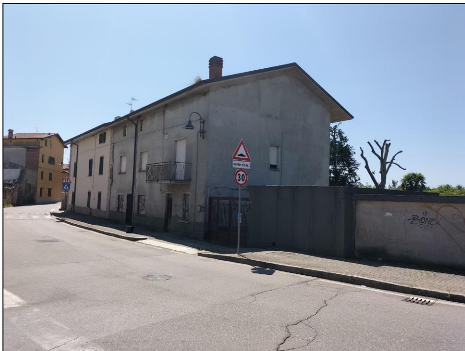
Fig. 13.33a - Edifici lungo la via Medolago (lato Sud, in sinistra del T. Buliga). In primo piano (a destra del cancello) l'edificio ad uso box, in secondo piano (dopo il cartello stradale) le abitazioni.
