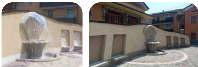
Manutenzione piazzetta San Rocco
