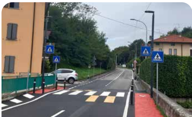
Attraversamento pedonale luminoso Via Milano
