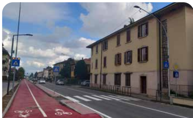
Attraversamento pedonale luminoso S.P. 166
