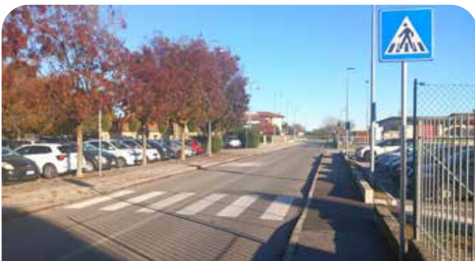
Nuovo attraversamento scuole
